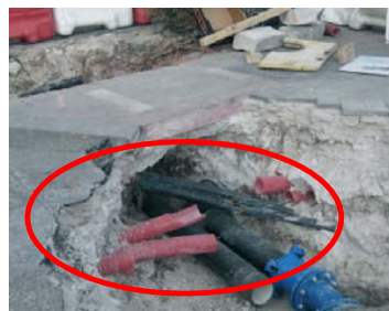
Rotura de los conductos de protección
