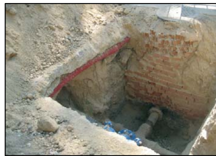
Acopio en borde de la zanja, provocando una sobrecarga estática.
