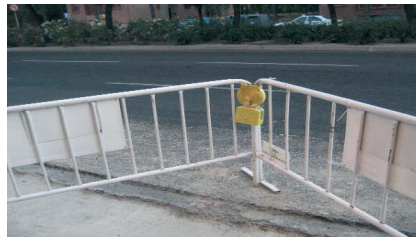
Luz Ambar intermitente, ubicada de forma INCORRECTA ya que está en el interior
