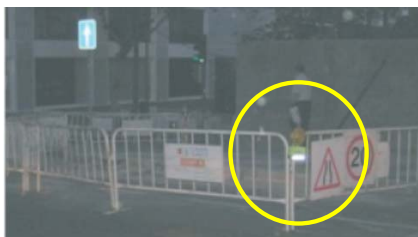
Luz Ambar intermitente, ubicada en el Ángulo saliente. CORRECTO
