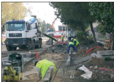
Vertido de hormigón con canaleta.
