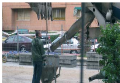
Utilización de cubos para vertido: precaución durante su elevación y recepción.
