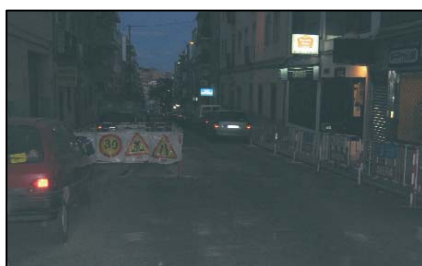
Señalización de obra, señales NO Reflectantes
