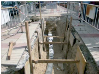
Sujeción de paredes de la zanja mediante Tableros horizontales y velas apuntaladas por codales.
