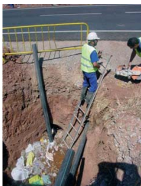
Acceso a zanja mediante escaleras
