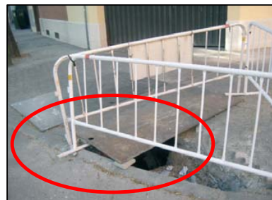
Apoyo inestable de la chapa
