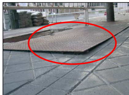
Chapa con las puntas levantadas, que puede dar lugar a accidentes de peatones
